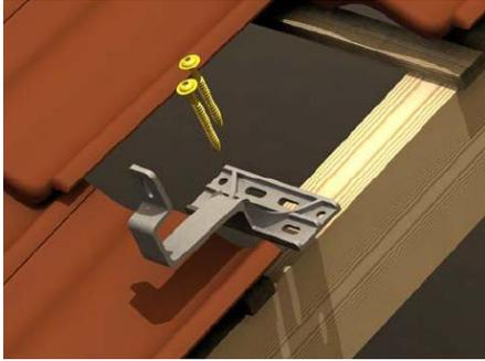
Die Befestigungswinkel werden auf den Sparren angebracht (oder den vertikalen Latten an den Sparren befestigt).
